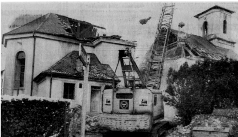
Die Niederbühler Kirche wird der Gewalt des Baggers. Quelle BNN vom 29.11.1978
